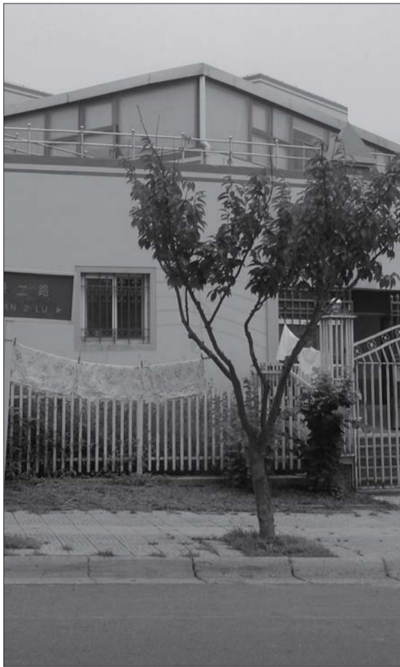
平台上的尖顶房就是被举报的违法建筑。
