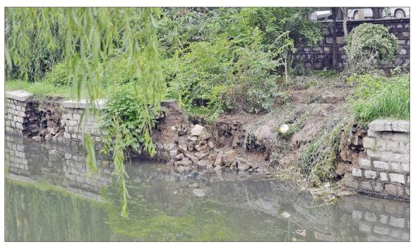
本报8月1日讯(记者 任志 王光照) 1日上午9时许,济 南市东工商河标山路与北园路 之间部分岸墙出现坍塌现象,墙 体及周围树木跌落至河道中,坍 塌段大约50余米,未造成人员伤 亡。据相关部门介绍,东工商河 岸墙因年久失修最终造成坍塌。 不过,有市民认为,河道附近路 面的积水直接排到河岸上,连续 冲刷造成河岸泥土松软,是造成 坍塌的重要原因。
