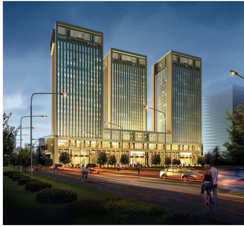
龙奥金座位于经十路和奥体东路交会口东南角，紧邻奥体东荷馆，位置绝佳，将建成“国家级三星绿色节能建筑”。据工程人员介绍，目前项目施工进度飞快，已经建设到19层(规划19层)即将盛大封顶。咨询热线：0531-82789999/0999
