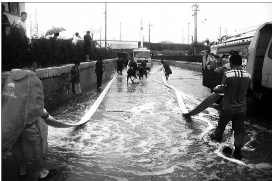
8月1日,新河路铁路涵洞下积水3米多深,市政、消防等部门对此路段进行紧急排水。 本报记者 马志勇 摄
