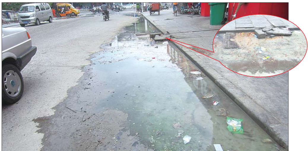
大图:污水越冒越多,向东漫延到牡丹路上。 小图:夹杂着饭渣的污水不断地从下水道井盖冒出。 本报记者 邢孟 摄
