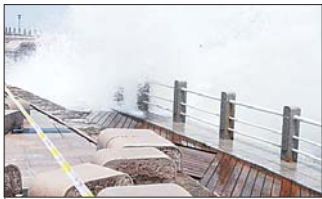
去年8月8日,灯塔广场景区,栈桥压顶石被台风“梅花”吹得七零八散。(资料片)
