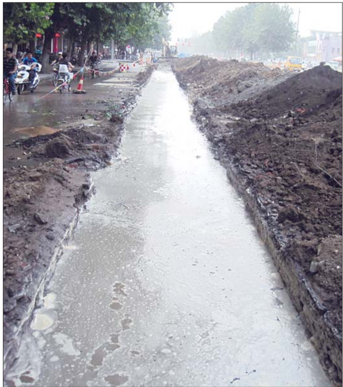
用于铺设管道的沟内已经灌满了水。王洪磊 摄
