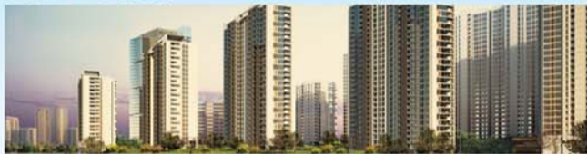
房屋建筑：施工总承包壹级资质
