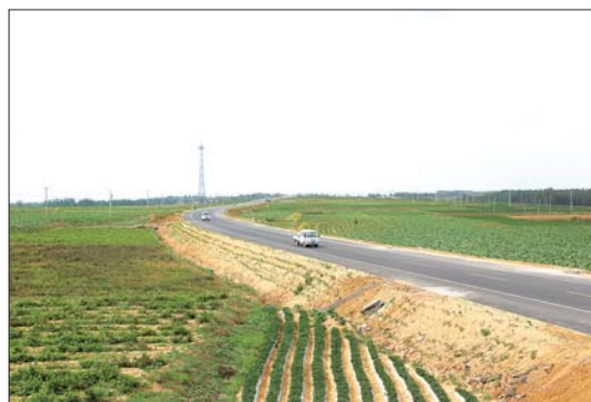
大修竣工通车的洛(河)安(庄)路。
