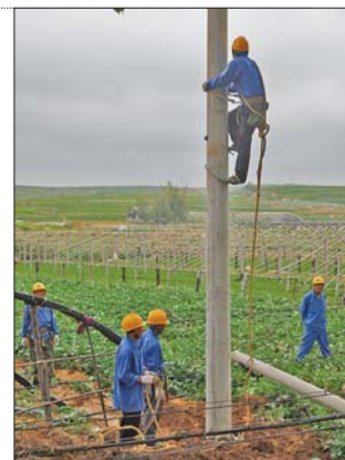
日照供电公司的抢修人员正在抢修线路。冷炳豪 摄
