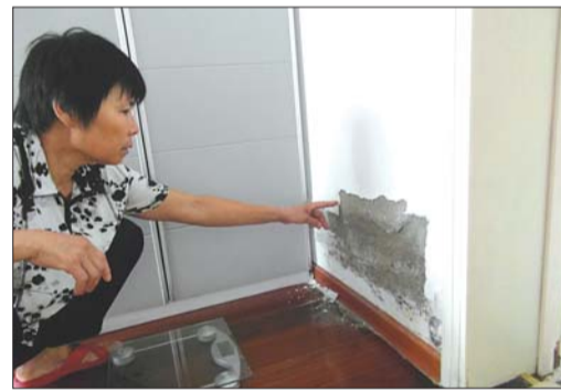
墙皮成片剥落。 张頔 摄
