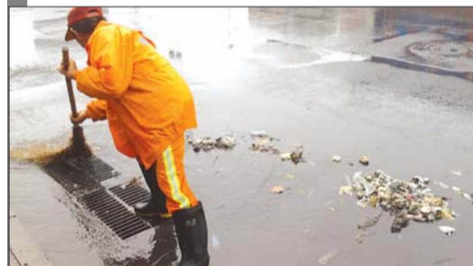
5日下午,历山路东侧解放桥附近,五颜六色的塑料袋堵塞了一个方形井盖子,一名清洁工脚蹬雨靴,手握扫帚,在积水中奋力清扫卡在井盖上的杂物。 本报见习记者 张亚楠 摄
