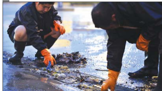
5日下午,解放东路,三箭平安苑附近的道路上积水严重,车辆和行人都不敢通过。图为市政人员正在清理排水设施上的杂物。 本报记者 蔡旭超 摄
