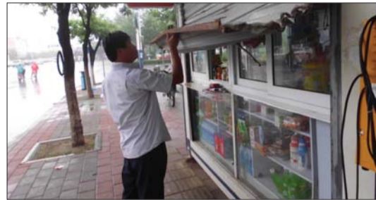
在东昌路、花园路路口,王先生掀起被损坏的卷帘门。 本报见习记者 郭庆文 摄
