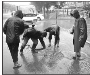
城管工作人员正在雨中更换井盖、清淤。 本报通讯员 于惠 摄
