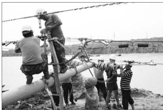
沾化35千伏滨海线线路抢修。本报见习记者 杨青 摄
