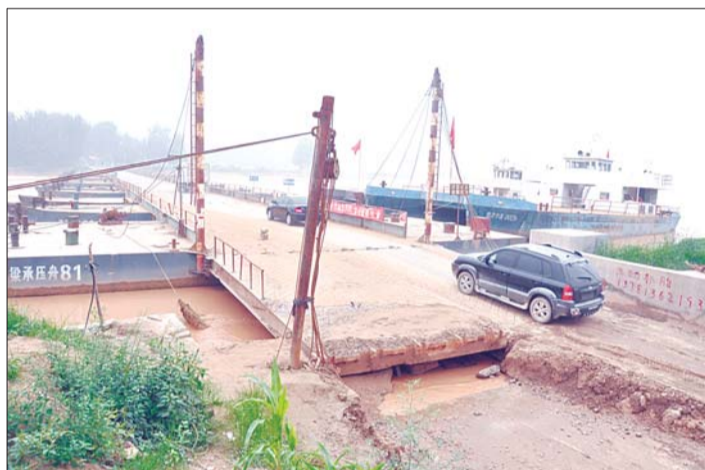
将军渡浮桥已恢复通车。本报记者 李蕊 摄
