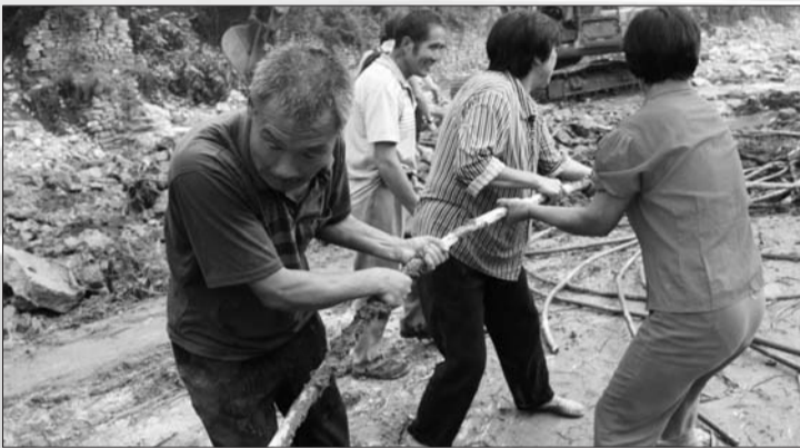
7日,在青州庙子镇南屋子村,村民正在抢修自来水管。
