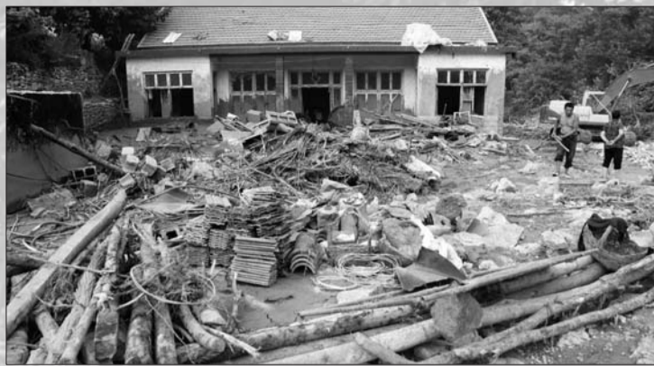
7日,在青州庙子镇南屋子村,一处被洪水冲毁的房屋。
