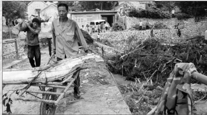
7日,在青州庙子镇唐庄,村内主桥上的护栏被冲毁。
