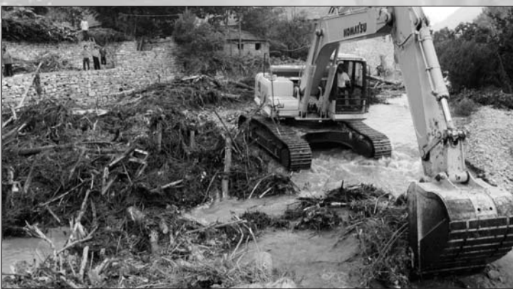
7日,在青州庙子镇,连接唐庄东西村唯一的一座桥正在抢修。
