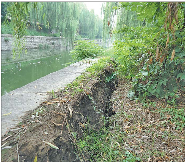
东工商河河堤发生坍塌前，就已经出现了一条30厘米宽的裂缝。天桥区排水管理服务中心供图
