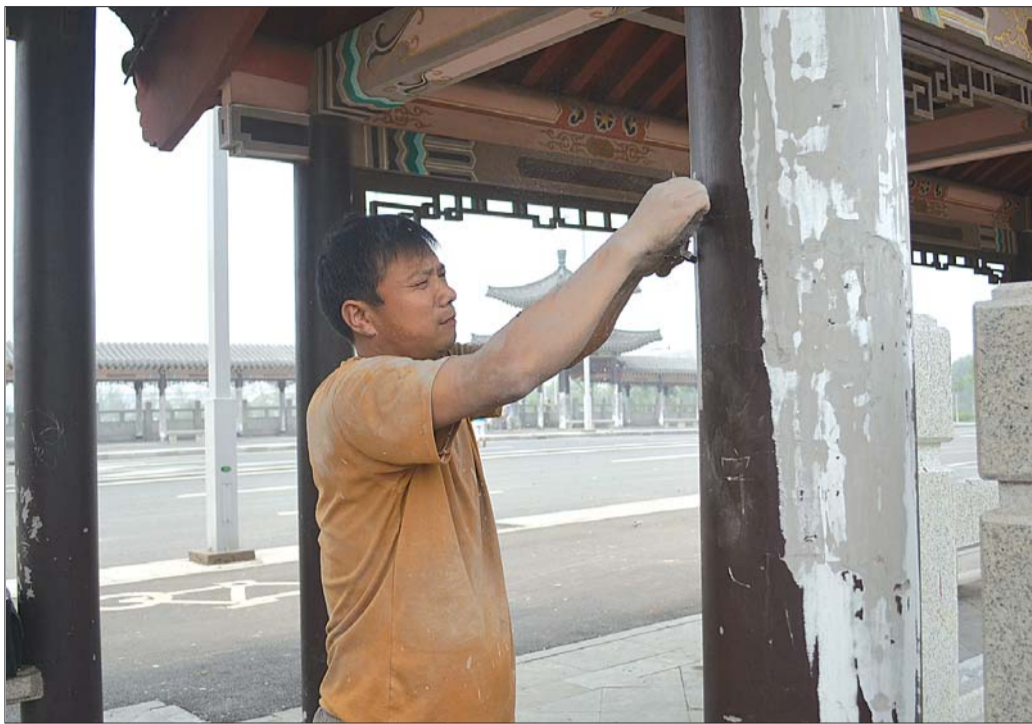
工作人员正在对廊柱进行清理。
