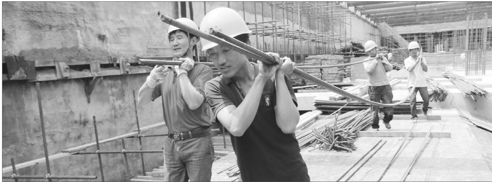
地铁施工人员烈日下来回多次搬运十多斤重的钢筋。蓝娜娜 摄
