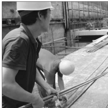
地铁施工人员在烈日施工。蓝娜娜 摄
