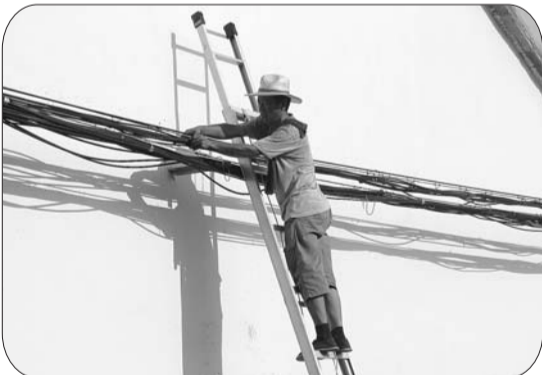
8 日下午,抢修人员在高空作业。
