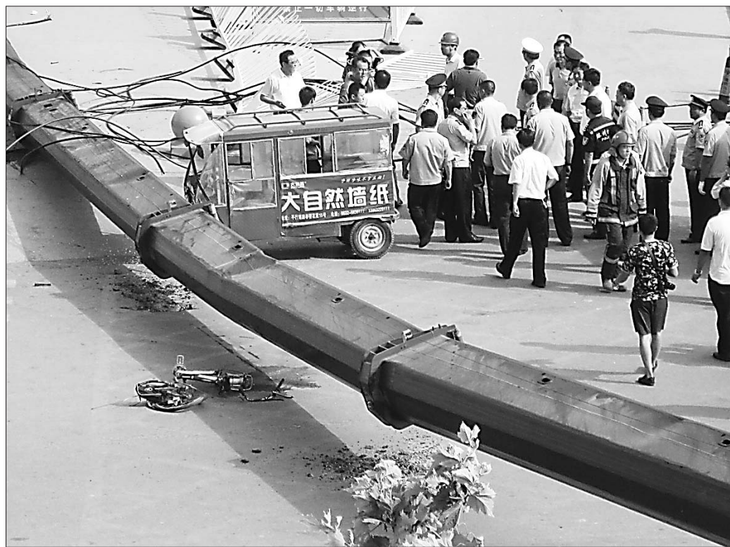
自行车被吊车塔臂砸在下面。
