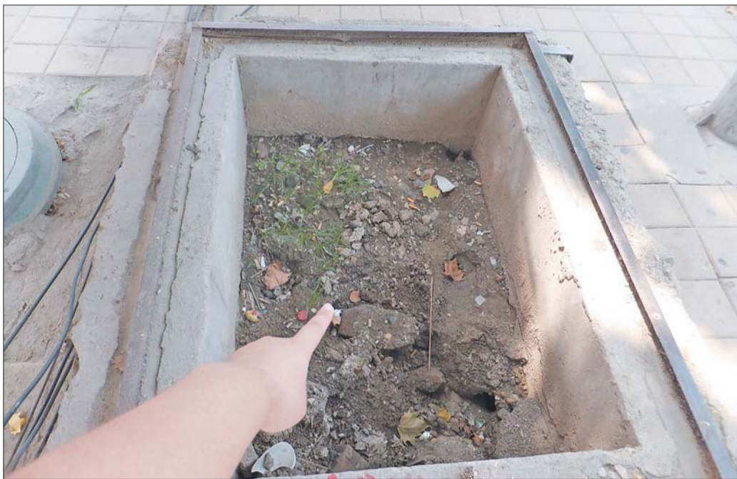
在济泺路上,一处下水井被泥土堵死了。记者 赵伟 实习生 胡玉婷 摄
