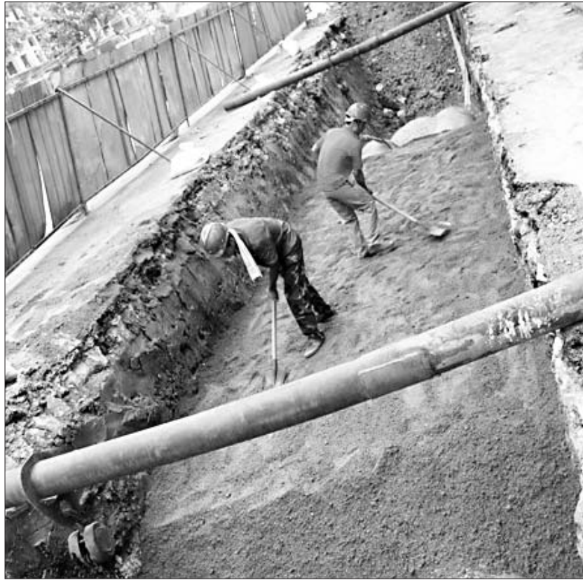
薛城区永兴西路,城区供热主管网配套工程项目正在紧张地进行施工。
