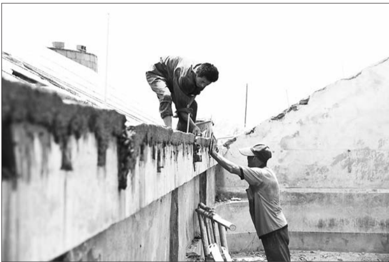
6日,市民在对被台风破坏的养殖大棚进行修复。
