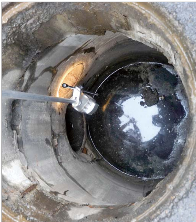
工作人员用内窥镜检查雨水管道的淤积情况。
