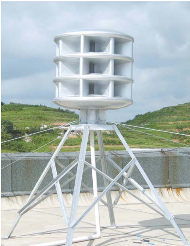
图为电声警报器,也是当前国家提倡推广的防空防灾警报,它能整点报时。(通讯员供图)
