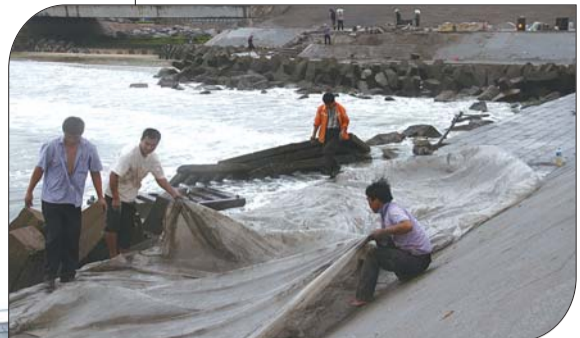
▲在栈桥的护堤上, 施工人员用塑料膜盖住刚刚修复的区域。
