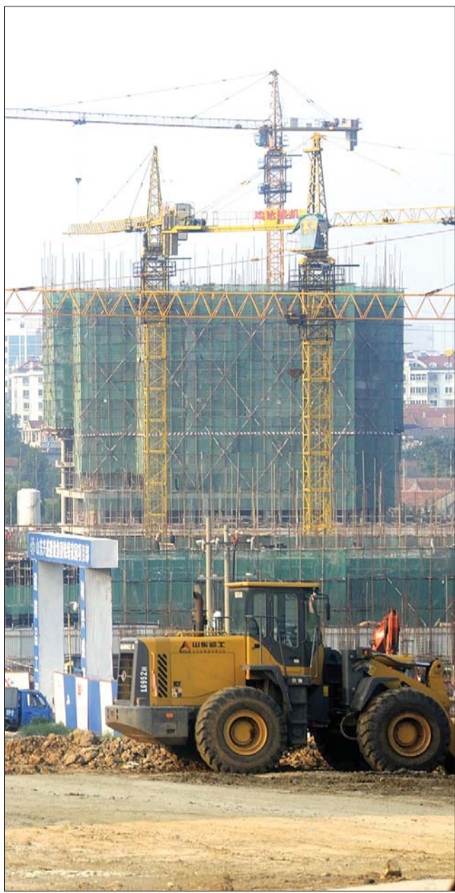
正在建设中的锦绣家园保障性住房。本报记者 李泊静 摄
