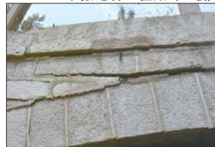
▼危桥凹陷最深处已下沉近一米。
