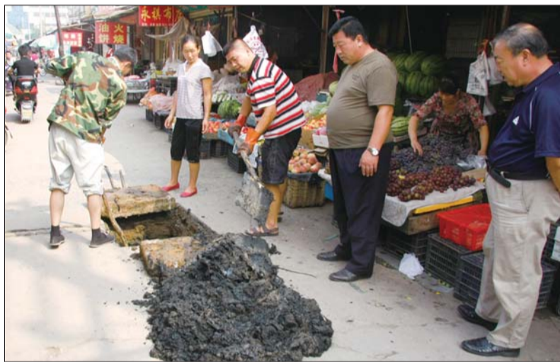
▲清淤工人在给下水道清淤。 本报见习记者 王鸿哲 摄
