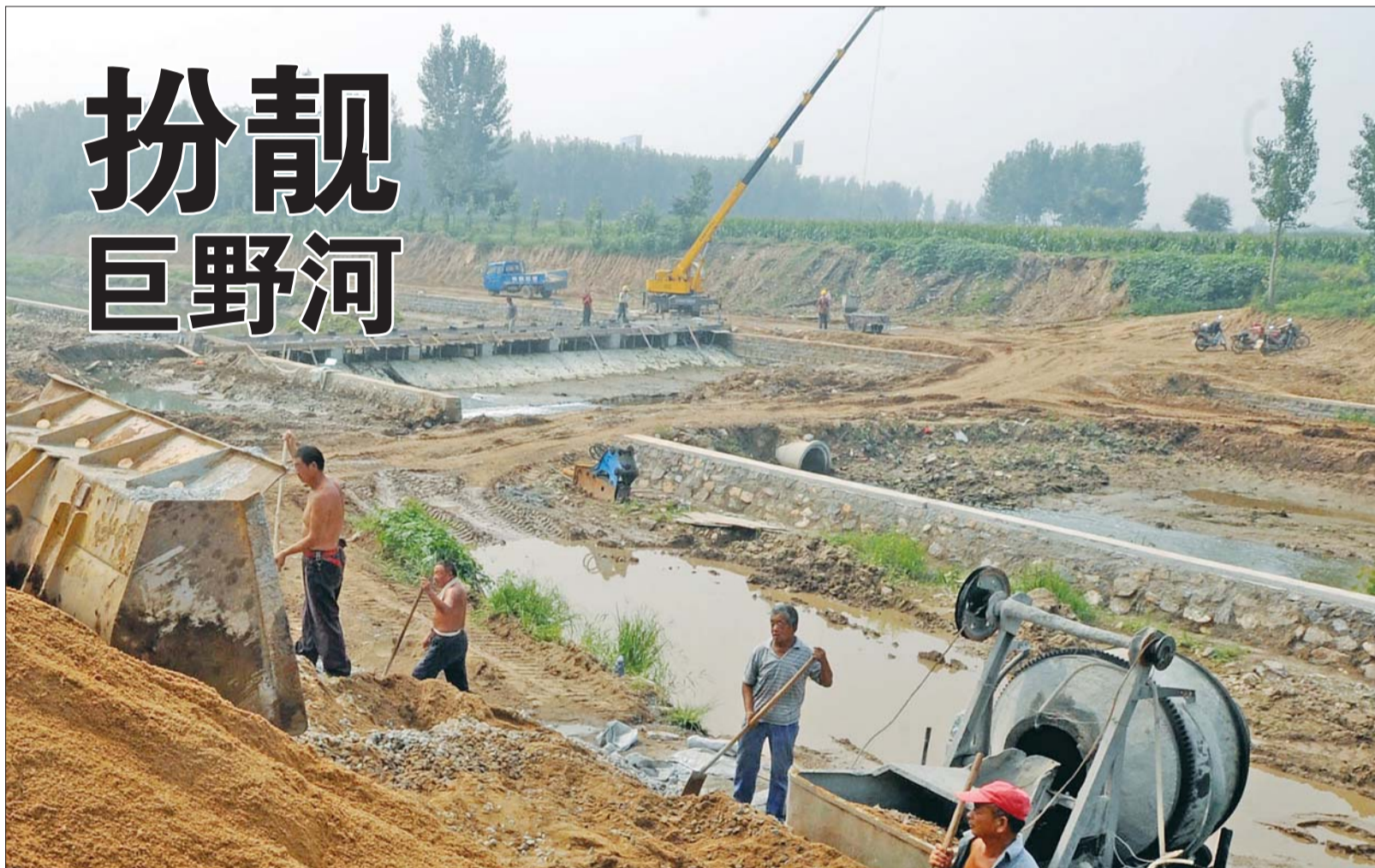
17日上午,巨野河纸房村段,十几名工人正在对河道进行拓宽改造,并建设各种景观。目前,巨野河二期改造工程正在进行,整个工程将分五段进行施工,打造多处景观和亲水平台,预计8月底基本竣工。 本报记者 左庆 摄
