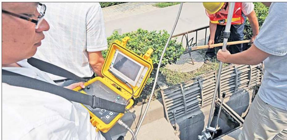
◀17日,工作人员用探测仪查看历城区一处地下排水道。 本报记者 戴伟 摄
