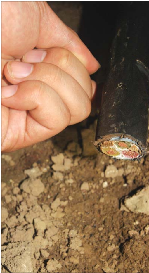
被犯罪嫌疑人割断的电缆。(警方供图)
