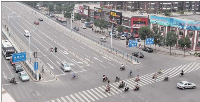
改造后的纬六路高架桥南段。 槐荫交警 提供
