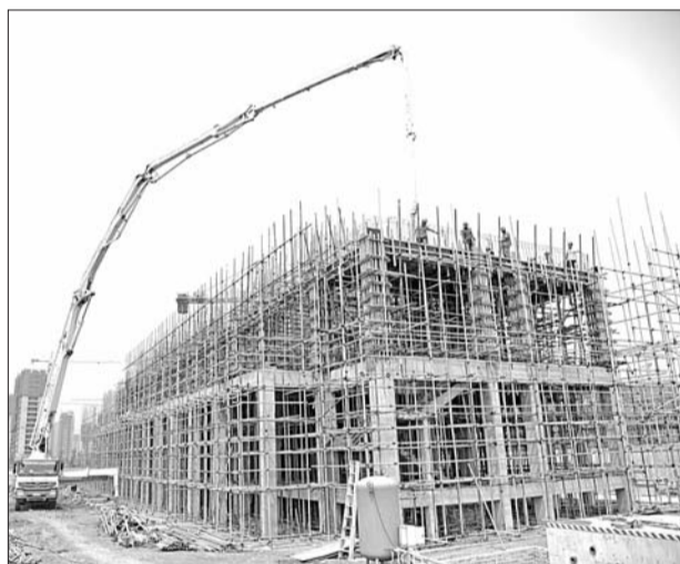
北湖输变电站正在紧张建设中。本报记者 刘守善 摄
