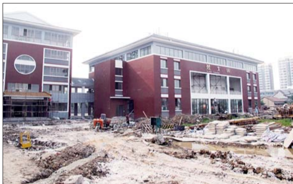
南池小学校舍主体已经完成。
