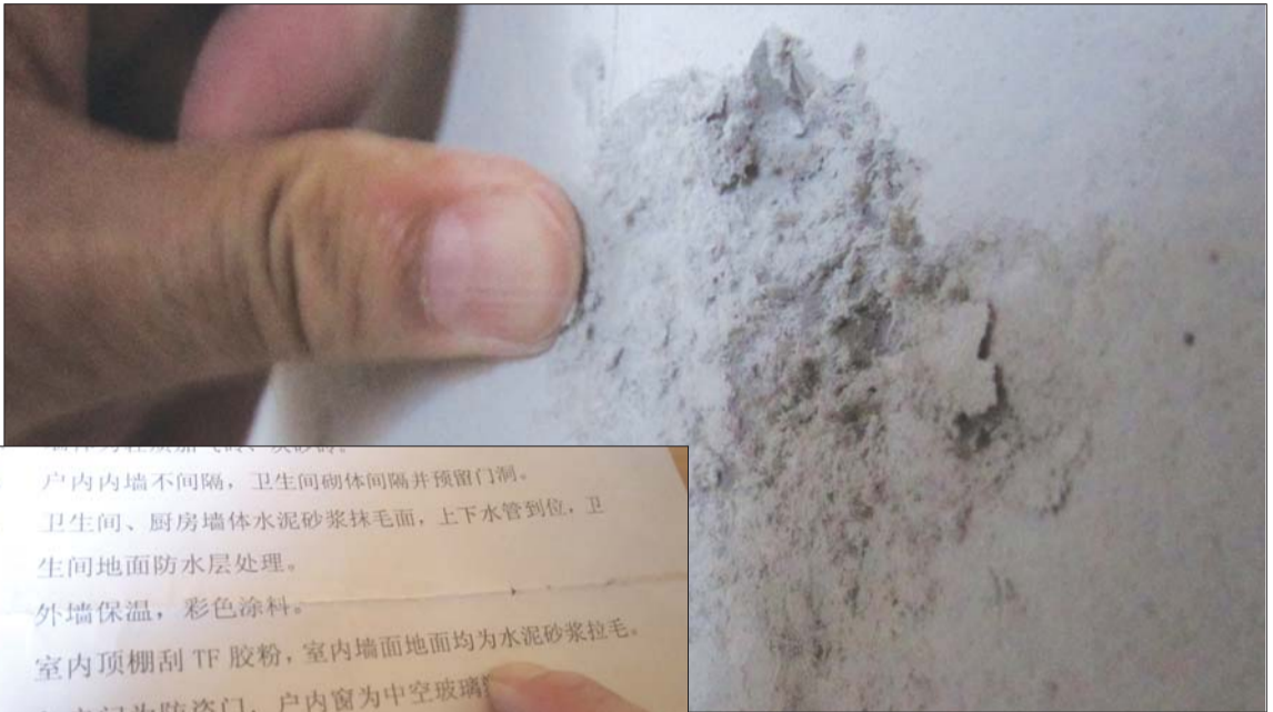
▲隋先生用手一刮,墙面就掉下灰色粉末状物质。 ◀合同上写着“室内墙面地面均为水泥砂浆拉毛”。
