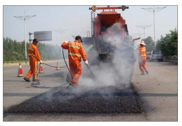
本报8月28日讯(记者 董惠)一块约 12平方米的网裂路面,在经过热再生修 补车加热、耙松、再生、摊铺、压实等工序 后,20分钟就修补完了。28日,记者采访 了解到,传统方法在修补网裂路面时,往 往需要较多人手,且花费好几个小时,而 引进热再生修补车后,就可直接对网裂 路面进行"焊接",省时省力。
