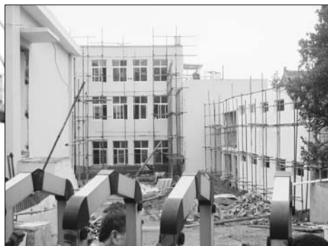
太平路小学校舍改造现场。李珍梅 摄
