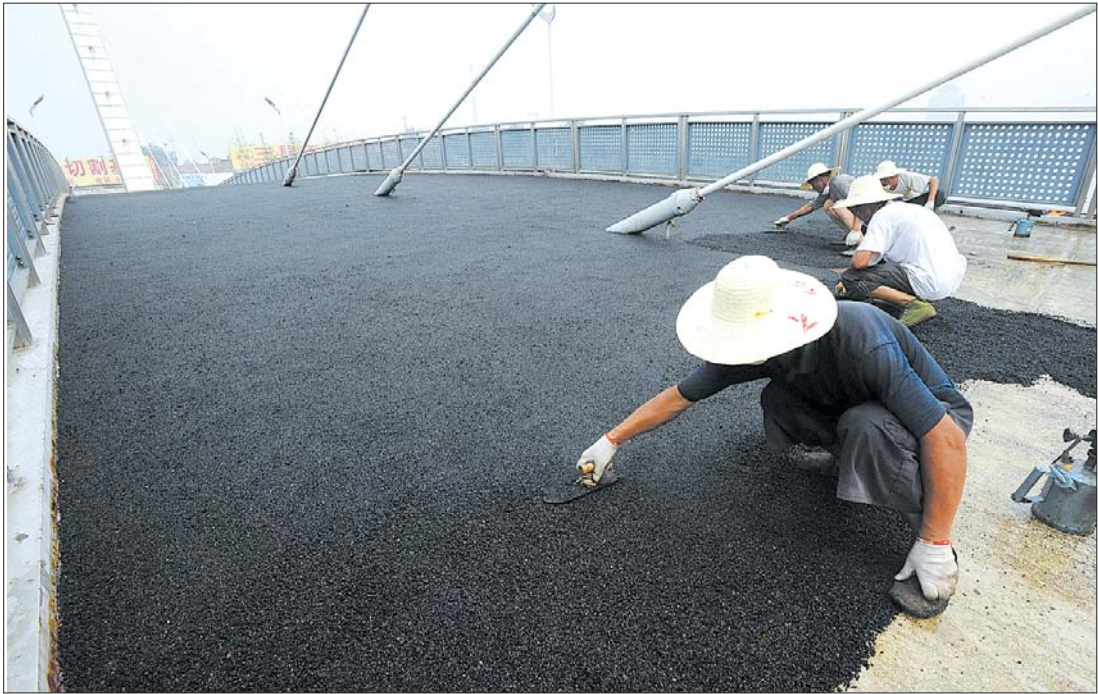
8月31日,施工人员正在小清河黄台码头桥上铺设彩色沥青。黄台码头桥是一座双塔斜拉式人行桥,由于之前铺设的塑胶路面出现破损,工人近期对路面进行整修,将黑、红两层彩色沥青铺设完毕之后,预计9月2日市民即可上桥游玩了。 本报记者 王媛 摄影报道
