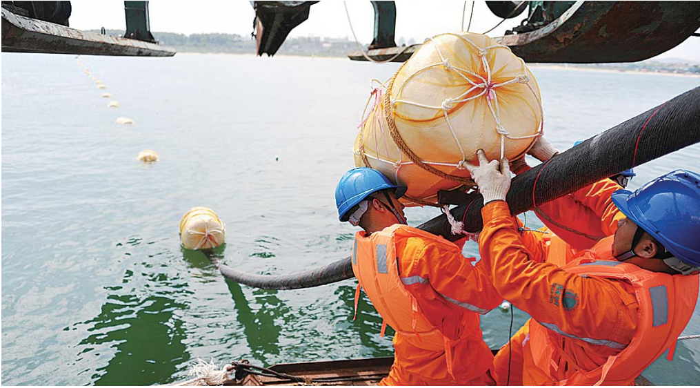
工程船上的工作人员向蓬莱岸边输送电缆。 本报记者 赵金阳 摄
