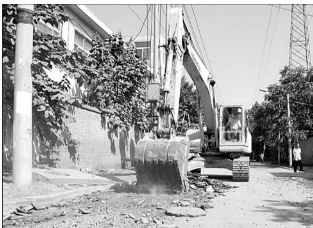
4日,挖掘机正在英华路上施工。
