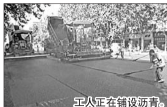
工人正在铺设沥青。
