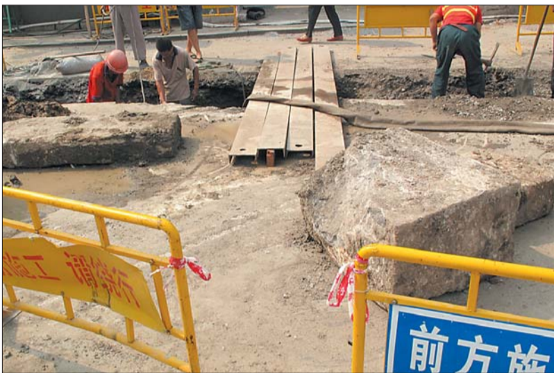
贡院墙根街南口市政施工挖出的3块石构件。 本报记者 乔显佳 摄
