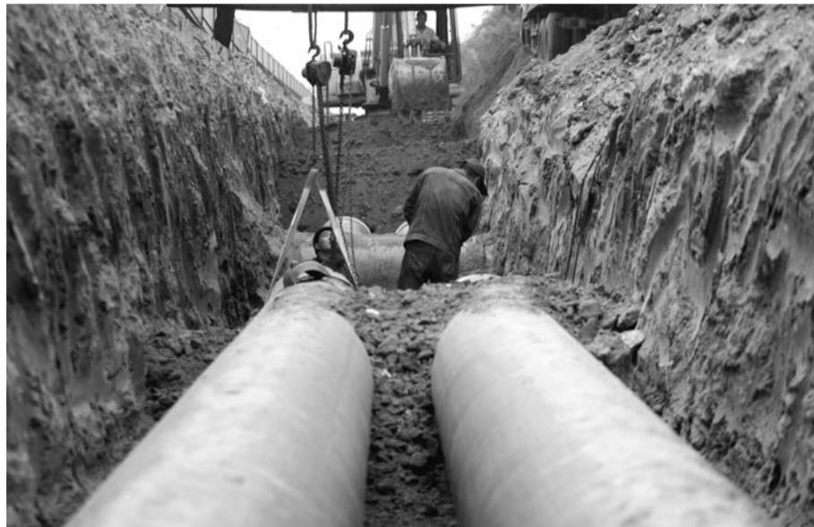
12日,在潍坊市玉泉路上,工人正在安装热力管道。据了解,高新区铺设热力管道,将蒸汽管道改为高温水管道,为了让市民按时用上暖气,工人正加紧施工。
