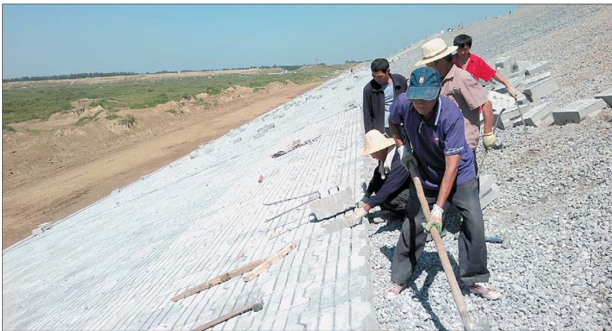
东湖水库建设现场,工人在铺装预制块。 本报记者 赵丽 摄
