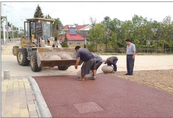
12日上午,施工人员在广场上安装圆形挡车柱,防止汽车压坏自行车道。
