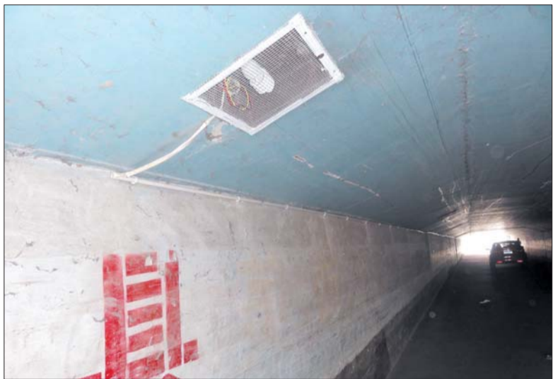
桥洞内新装路灯和防护网。 本报见习记者 宋磊 摄
