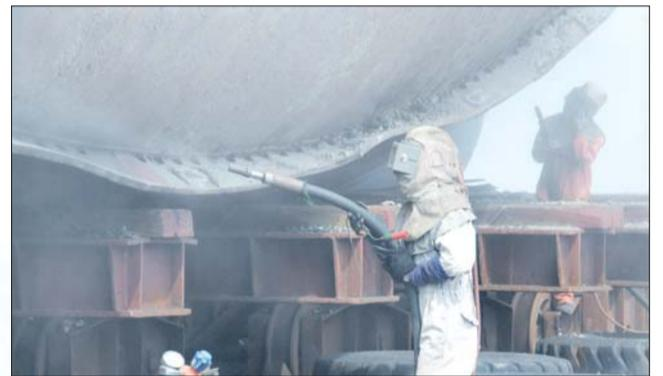
工人对船体喷砂,去掉长期被海水侵蚀的旧漆,涂装新漆。由于这一工作粉尘量大,工人在操作时都戴上防毒面具。
