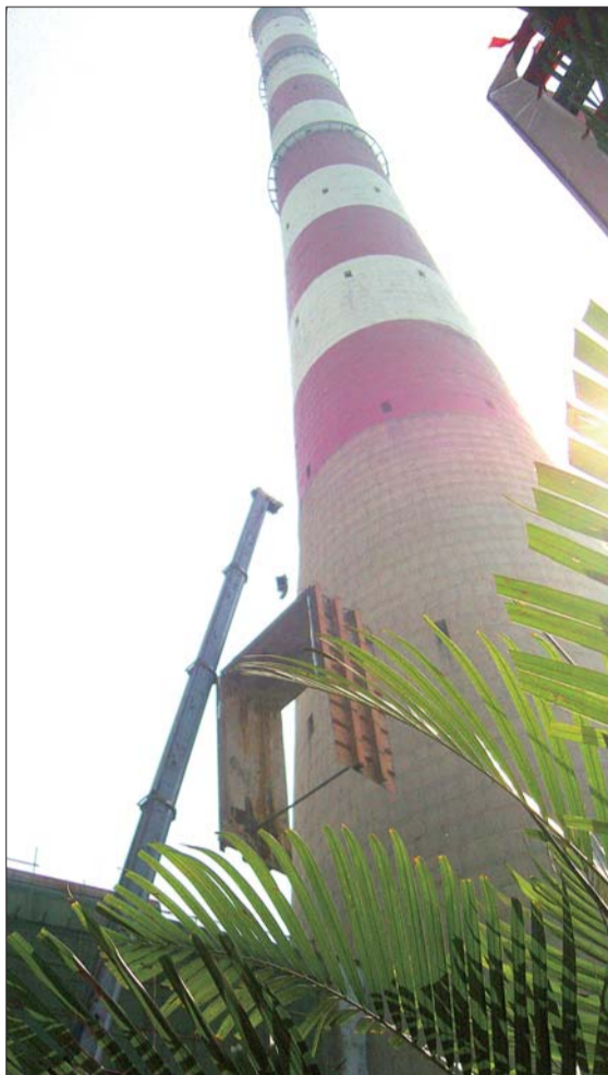
国电石横电厂1号机组脱硫烟气旁路拆除现场。
